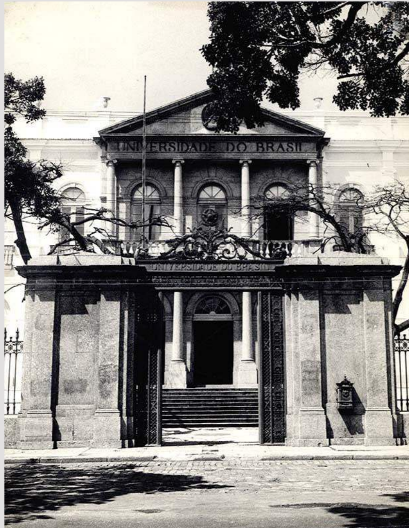
FIGURA 73 Fachada do Palácio Universitário da Universidade do Brasil, criada em 1937, onde antes funcionava o Hospício Pedro II
