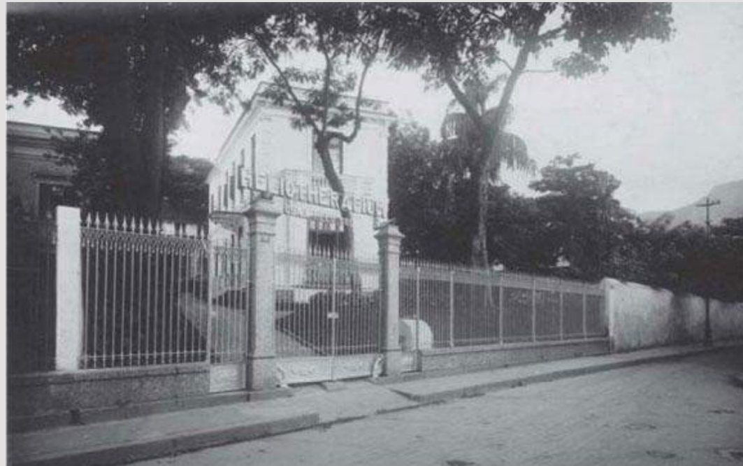
FIGURA 101 Fachada do Heliotherapium
