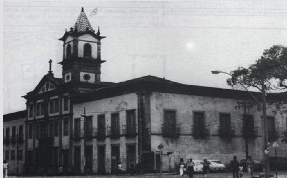
FIGURA 1 Foto antiga da Santa Casa de Misericórdia de Salvador
